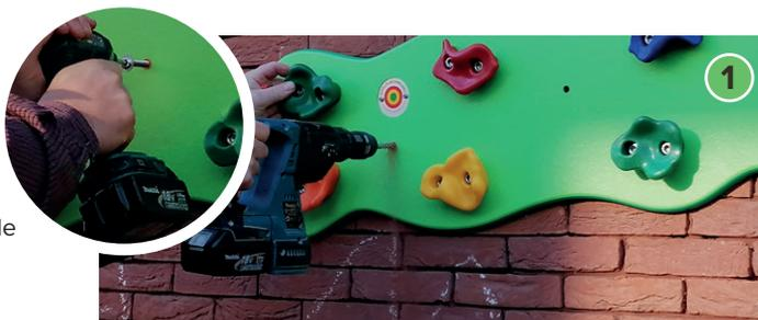
2. Forez dans le mur à travers les trous pré-forés dans les planches. Insérez la cheville dans le trou avant d'y insérer la vis
